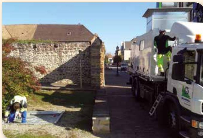
Du 12 au 20 octobre dernier, les habitants ont pu observer la station de lavage roulante de la société SIRMAT-SCHROLL œuvrer au sein des 9 communes de la CC PAROVIC. 31 conteneurs à verre enterrés ont ainsi pu être nettoyés et entretenus (graissage, petites réparations, ...). Cette opération permet de maintenir ces équipements en bon état dans le temps. Coût de l'opération : 6 286,80 € TTC.
